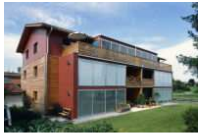
Die Sanierung von rund 30, 40 Jahren alten Gebäuden ist ein zukunftssträchtiges Geschäftsfeld für Zimmerer. Bilder: Ambros GmbH
