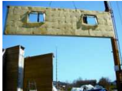
Die neue wärmebrückenfreie Außenwandhülle erreicht einen U-Wert von 0,12 W/(m²K).
